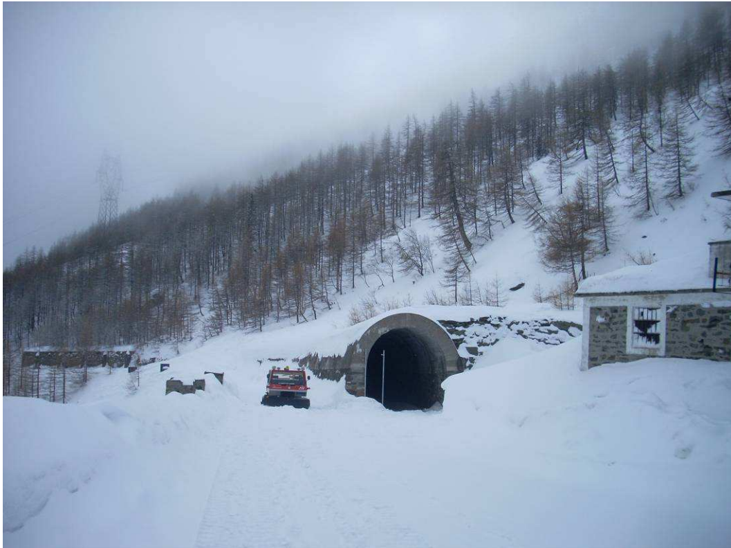
Galleria paravalanghe Ferrovia Fell al km 70 della SS25
