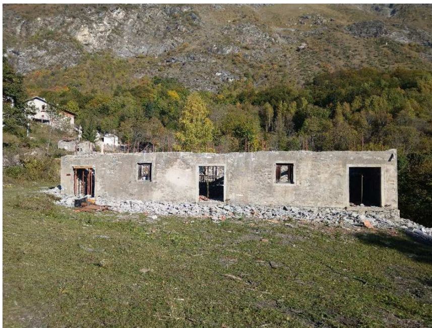
Situazione di fatto durante le opere di pulizia e consolidamento
