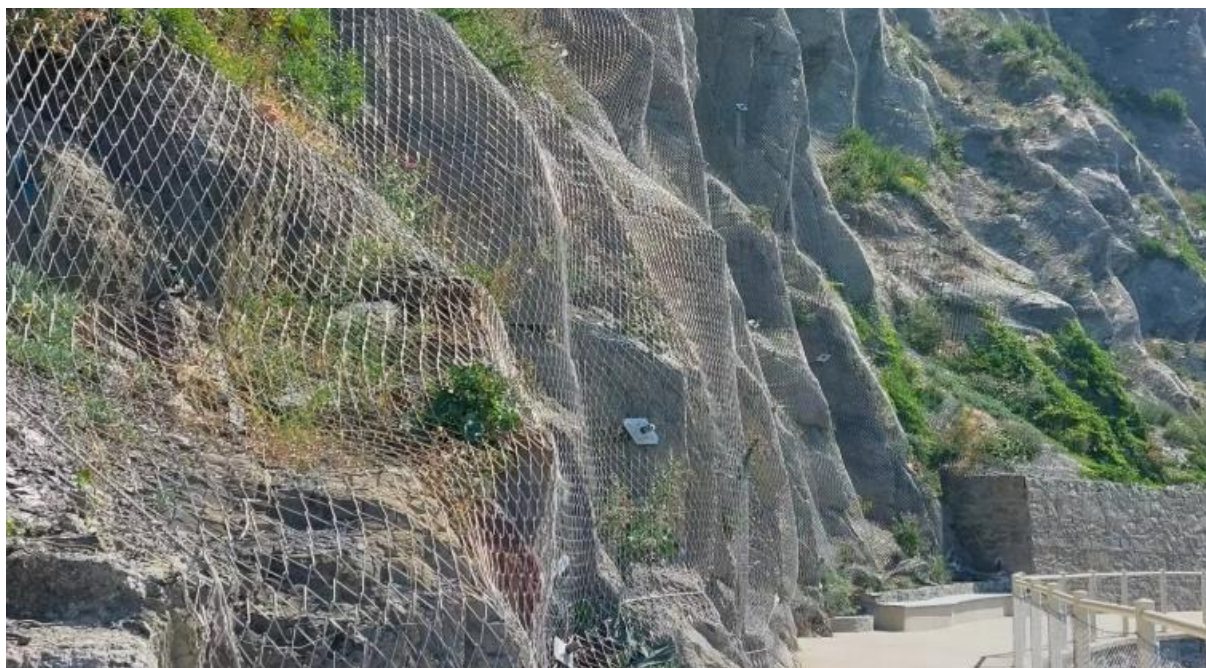
Figura 36 - Esempi di applicazioni di reti per rafforzamento corticale di versanti
