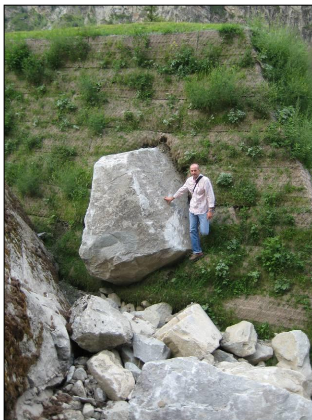
Fig. 4 - Vallo paramassi in Terramesh Verde realizzato a protezione della strada SR 47 in Comune di Cogne (AO), interessato da impatti multipli, sui quali è stata eseguita una back analysis con modelli numerici ad elementi finiti
