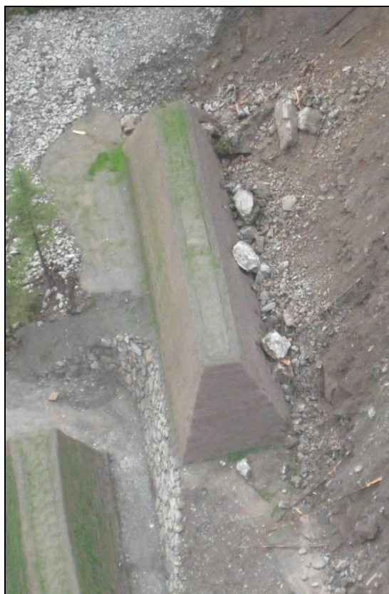
Fig. 4 - Vallo paramassi in Terramesh Verde realizzato a protezione della strada SR 47 in Comune di Cogne (AO), interessato da impatti multipli, sui quali è stata eseguita una back analysis con modelli numerici ad elementi finiti
